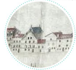
Façades non homogènes ABM, 1741
